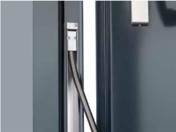
**Verdeckter Kabelübergang:** Häufig werden Türen mit elektrotechnischen Systemen gekoppelt. Hierzu gehören z.B. Fluchtwege- und Alarmtechnik ebenso wie Motor- oder Blockschlösser. Durch den verdeckten Kabelübergang wird die Gesamtoptik unserer Objekttüren nicht beeinträchtigt.
