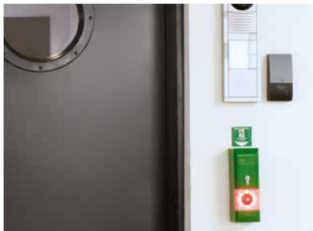
**Fluchttür-Terminal:** Im Alltag sicher verschlossen, bei Gefahr schnell und einfach zu öffnen. Dies sind die wichtigsten Anforderungen an Türen von Flucht- und Rettungswegen. Elektronische Fluchtwegsicherungssysteme unterstützen diese scheinbar gegensätzlichen Anforderungen.
